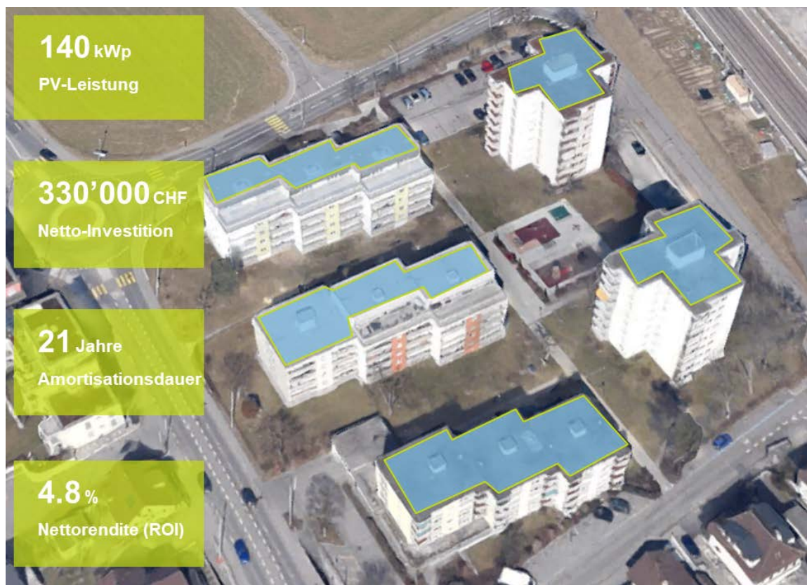
Abbildung 5: Sicht auf das Quartier Bahnhofmatte. Blau eingezeichnet ist die Fläche, welche mit Solarmodulen belegt werden könnte. (Quelle: Google Maps). Die Kennzahlen beziehen sich auf den Fall, dass alle Liegenschaften genutzt werden und 5 separate ZEV gegründet werden.
